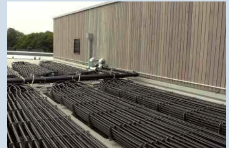
Abb. 36: Die Solarabsorberanlage auf dem Dach Foto: COPLAN AG
